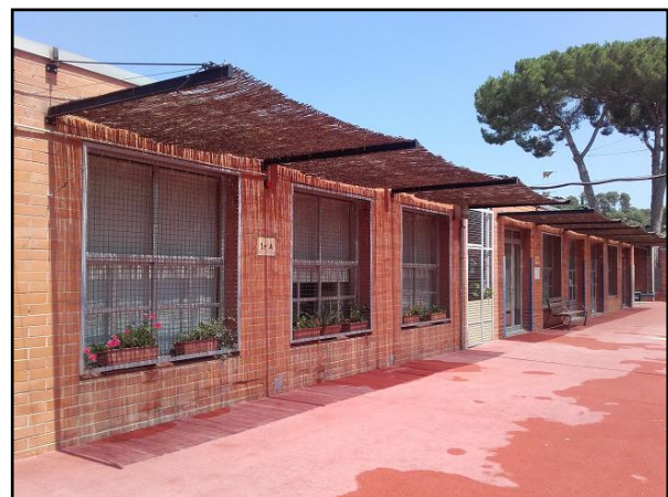
Marquesina de la paret sud
